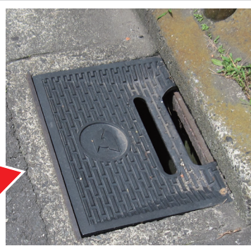
●破損した雨水マスの改修 (西小松川35)
